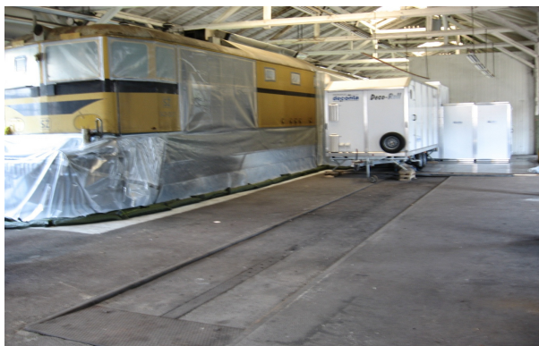
Priprava lokomotive ne odstranitev azbesta
